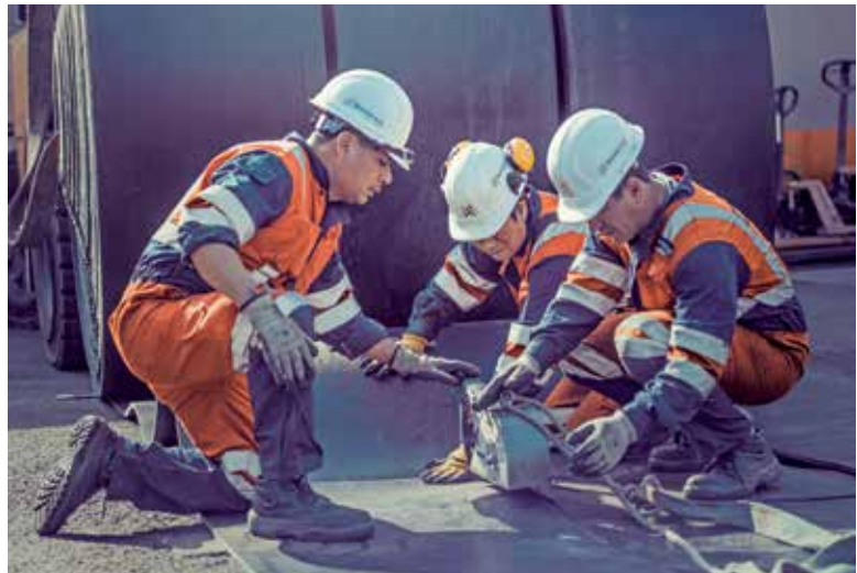
Movitécnica realiza el montaje de la banda transportadora y el servicio de vulcanizado, mediante el uso de equipos que generan presión y calor.
