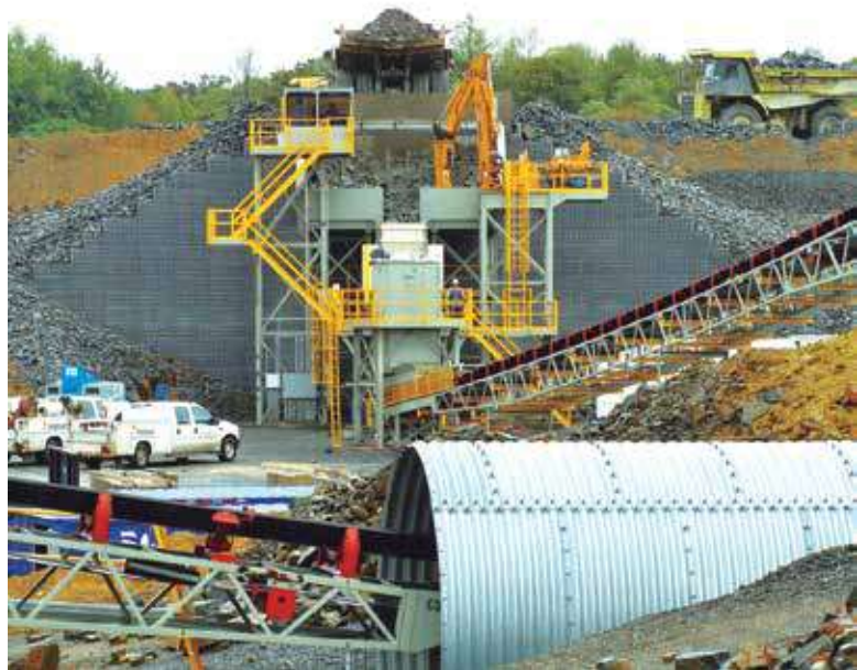
Los servicios de construcción agrupan tareas básicas como el movimiento de tierras; construcción de campamentos; diseño y construcción de presas de relave; entre otras actividades.
